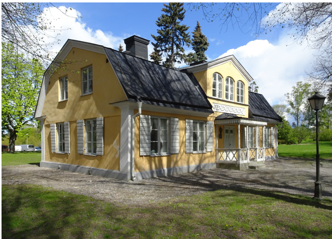
Figur 6. Annelunds gård, ursprungligen från 1700-talet, byggdes om av P.H. Ling till dess nuvarande utseende. Foto: Holger Ellegaard, Wikicommons.
